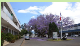
Entrée du Lycée
